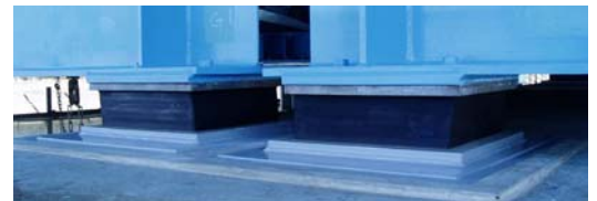
写真-2 支承写真(提供：東北地方整備局)
