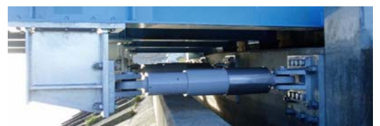
写真-3 ダンパー写真(提供：東北地方整備局)
