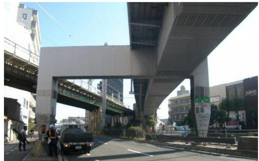
写真-1 上部工と剛結されたラーメン鋼脚
