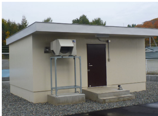
写真-1 地震計設置小屋(対震ハット)
