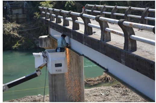
写真-2 下フランジ切り落とし作業
