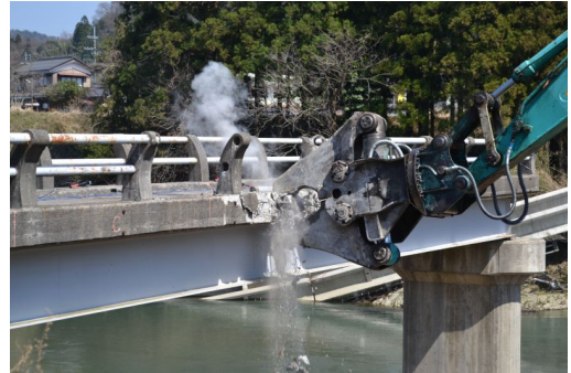
写真 - 3 床版の破碎
