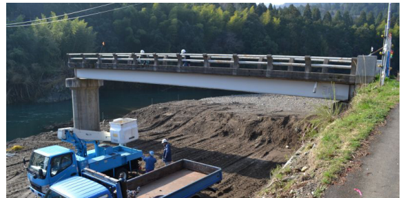
写真 - 1 被災後の様子
