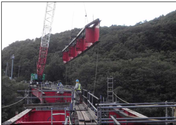
図-4 G3桁中央径間撤去状況
