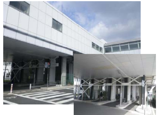
写真-2 振動対策ブレース
