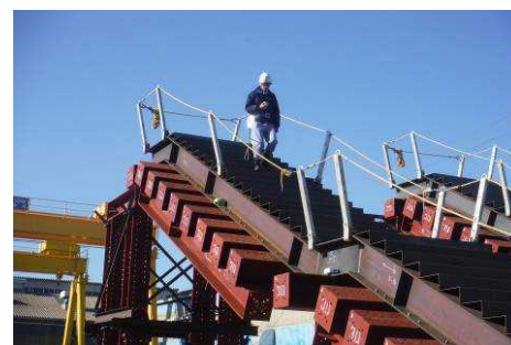
写真2 階段試験状況
