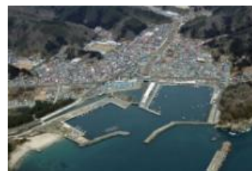
写真-1 田老地区の震災前 (2010. 3)
