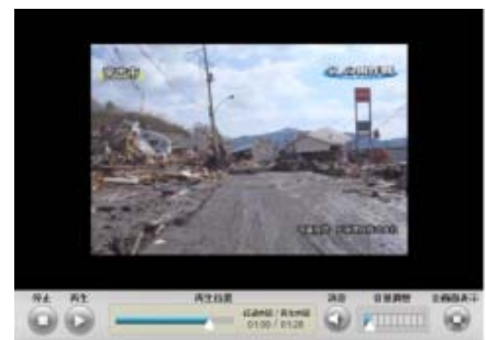
写真-3 道路啓開 (『現場の戦い』より)
