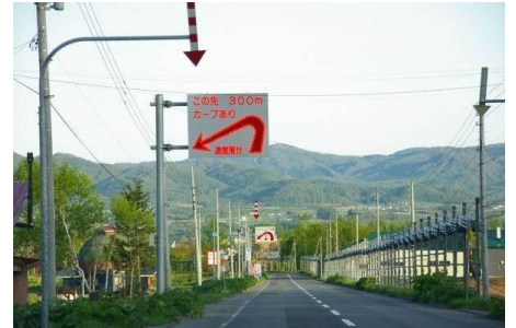
写真-1 道路附属施設の過剰な設置事例
