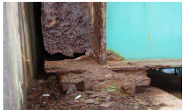
図-1 補修前の桁端腐食の状況例
