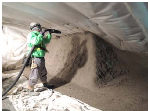
図-5 吹付け施工状況
