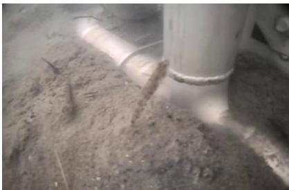
写真1 施工時の水底状況
