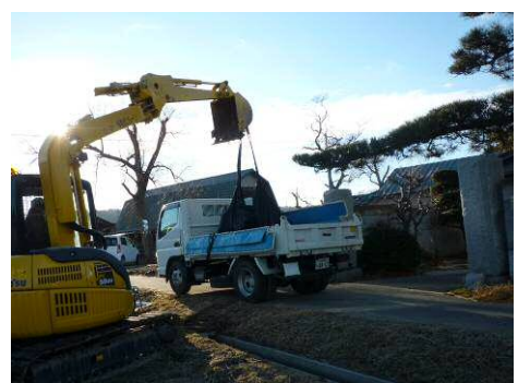
写真-5 処理土の移動状況
