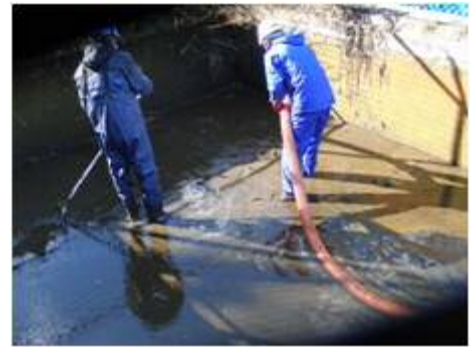
写真-2 底泥の除去状況
