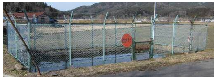
写真-1 防火水槽の状況
