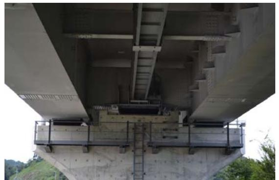
写真3 水平反力分散支承
