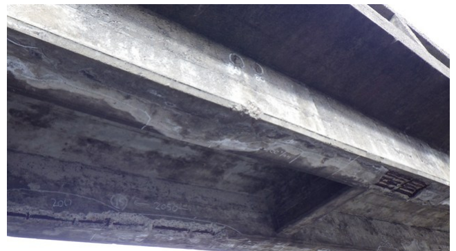
図-2 日月橋桁下の状況
