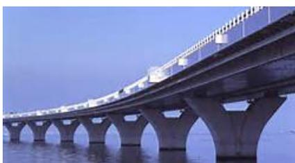
図1 10径間鋼連続桁
