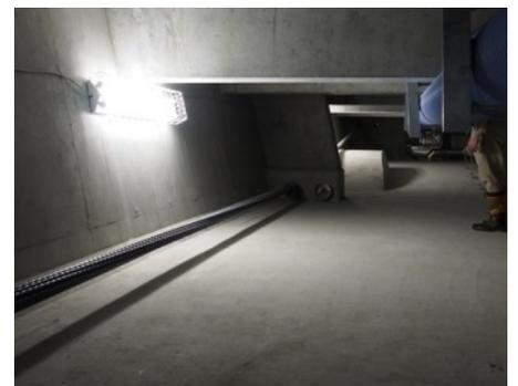
写真-2 桁内照明設備
