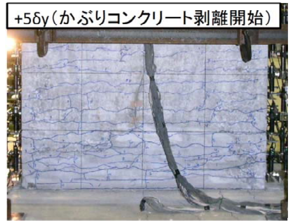
写真-1 限界変位時 \delta_{ls3} の損傷 ( 5\delta_y : ML 橋脚試験体)
