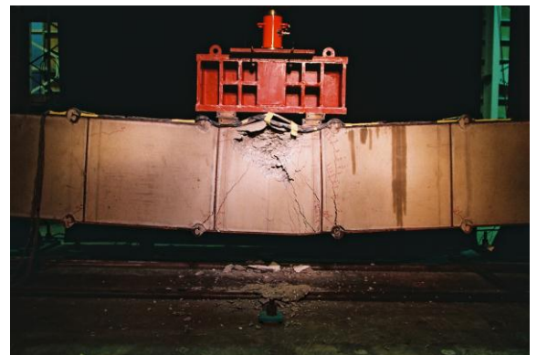
写真-1 ひび割れ状況
