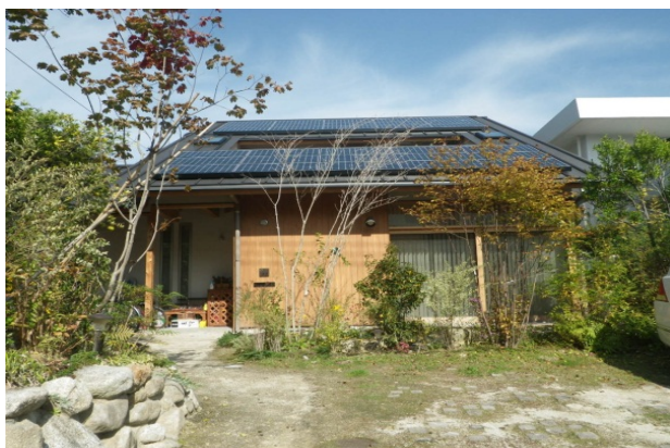
写真-1 雨水利用実験住宅外観
