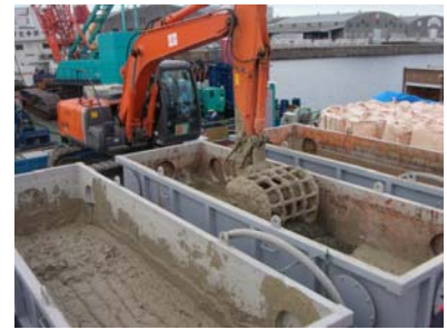
写真-1 土質遮水材料の混練り状況
