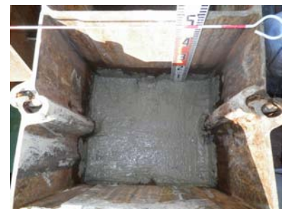
写真-3 遮水室内への充填直後の状況
