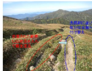
図-5 登山道の山側への振り替え(H24年施工区間の例)
