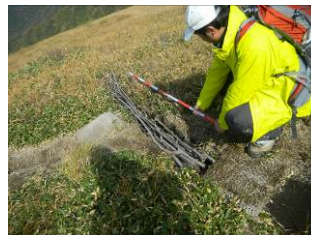
図-6 粗朶分水排水工の事例
