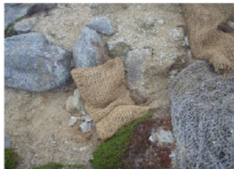
図-4 土嚢による土留め(三方境；朝日地域植生復元作業箇所)
