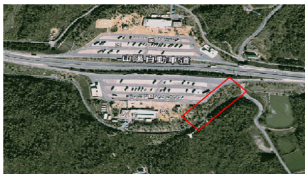
図1 UAV撮影箇所（三木SA：赤枠内）
