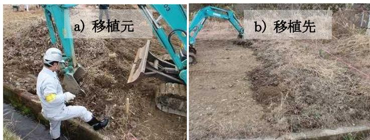
図3 重機による表土移植状況
