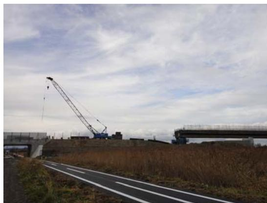
写真-2 橋梁による保全対策（送り出し工法）
