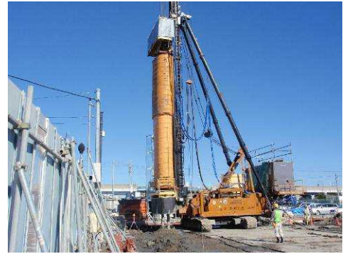
写真 2 深層混合処理の施工状況
