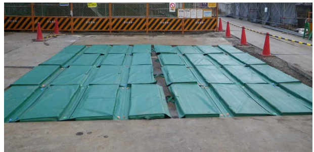
写真-1 防振マットの設置状況
