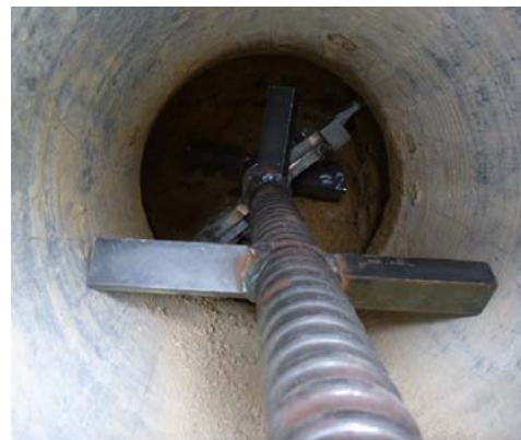
写真-3 擁壁躯体通過状況
