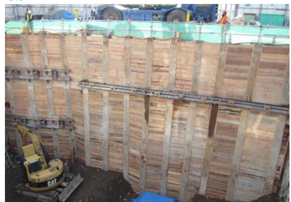
写真-1 掘削完了全景
