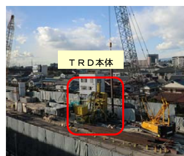
写真-1 TRD施工状況
