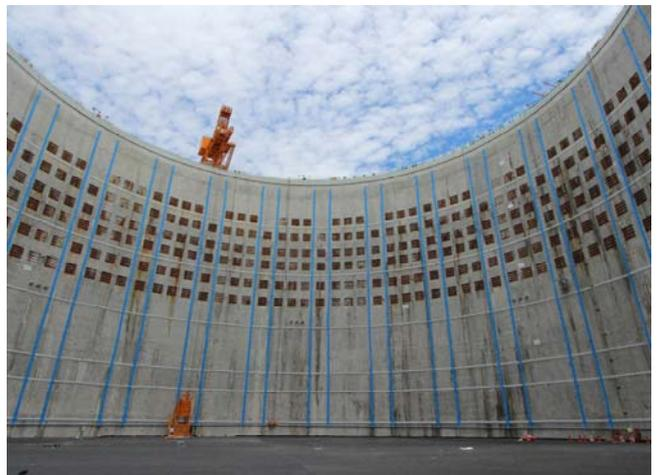
写真 1 構築した地中連続壁の外観
