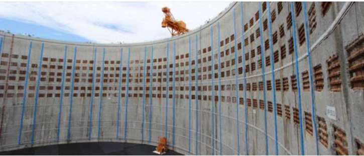
写真1 構築した地中連続壁の外観
