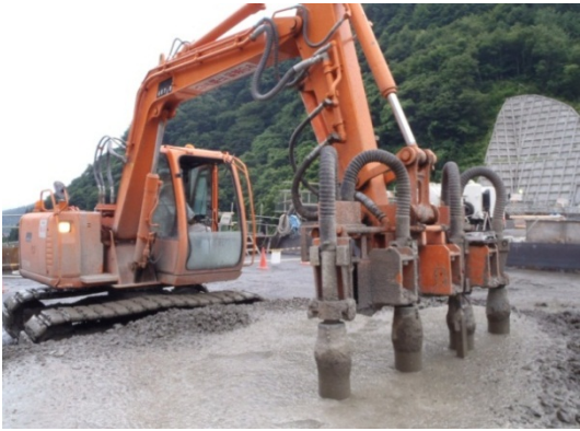
図-5 締固め判定現場試験状況
