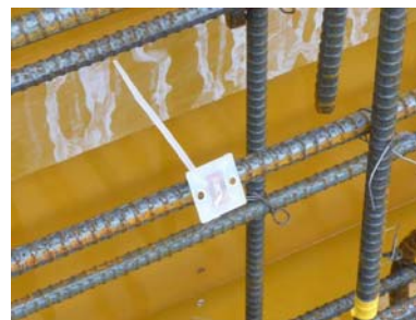
写真1 コンクリート打設前ICタグ設置状況
