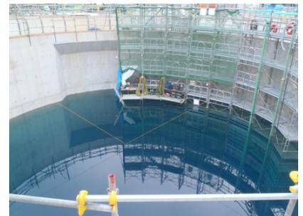
写真-6. シールド水中到達状況
