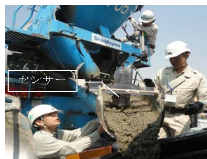
写真-2 現場における連続測定状況
