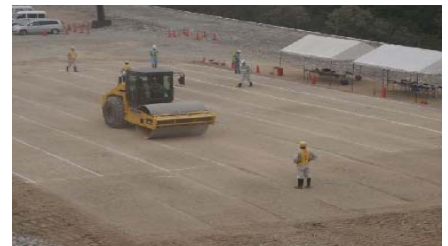
モデル施工の状況
