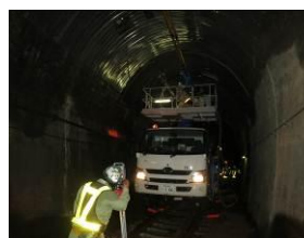
写真－５ 変状測定状況
