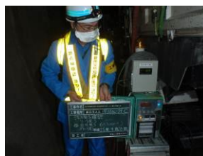
写真－４ 注入圧力管理状況
