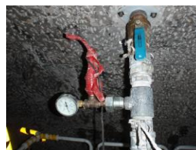
写真－４ 注入圧力管理状況
