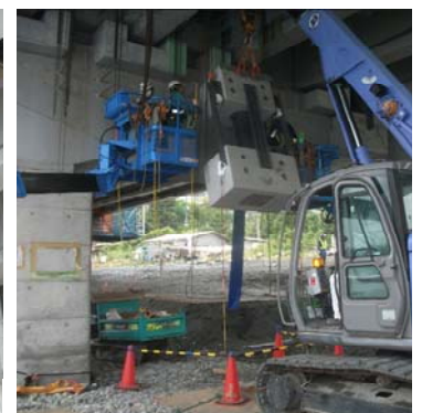
写真-5 円弧ダンパの揚重状況
