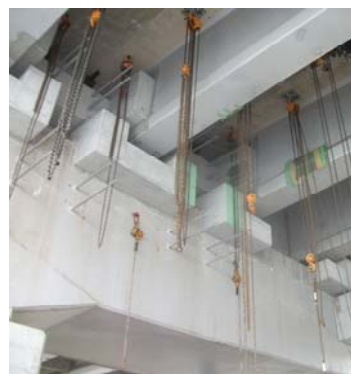
写真-4 床版下面へのチェーンブロック設置状況
