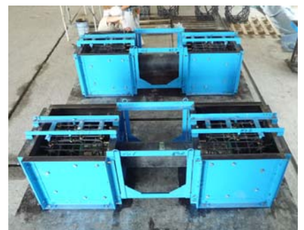
写真-3 取付ブロック部型枠セット状況（コンクリート打設前）
