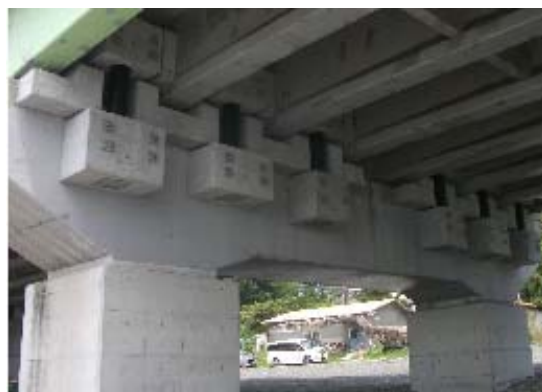
写真-1 円弧ダンパ設置状況
