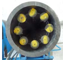
写真-2 PE 管内への鉄筋かごの設置状況（上方から撮影）
