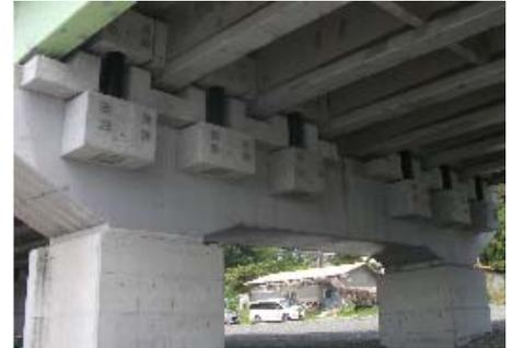
写真-1 円弧拘束型 RC ダンパ設置状況
