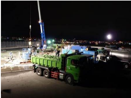
写真-1 施工状況
