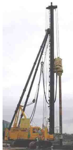
写真-1 施工状況
