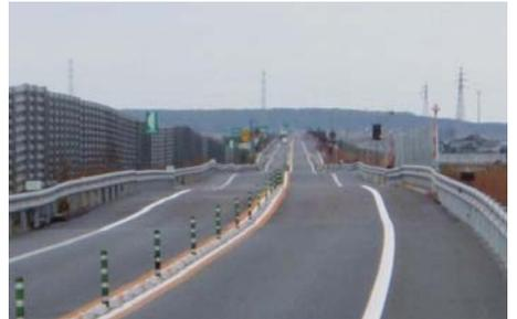
図1 長期沈下による縦断線形異常例
