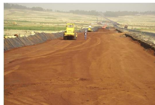
写真-2 BCS 対策工の施工状況
