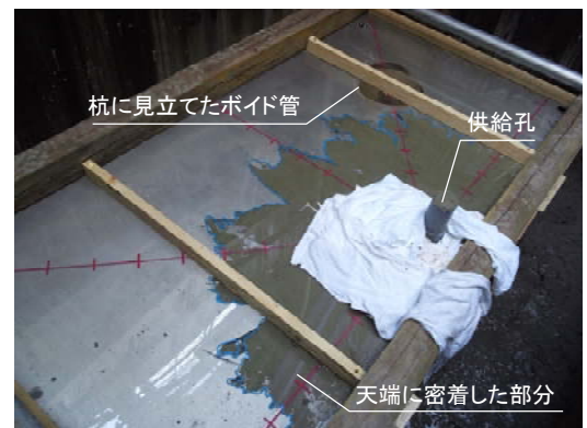
写真-3 打設終了後の状況
