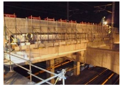
固定式吊り足場
