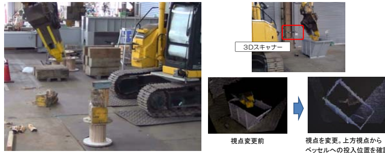
図-4 実証実験状況
