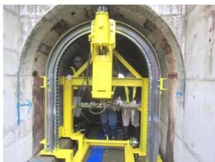
写真-1 自走式チップングマシン設置状況
