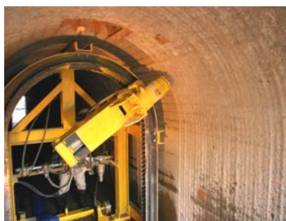
写真-2 チップング状況
