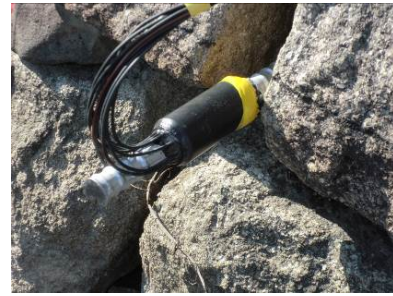
写真-2 打設後のモニタリング鉄筋（頭部）
