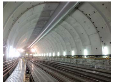
写真-1 セグメント組立完了状況
